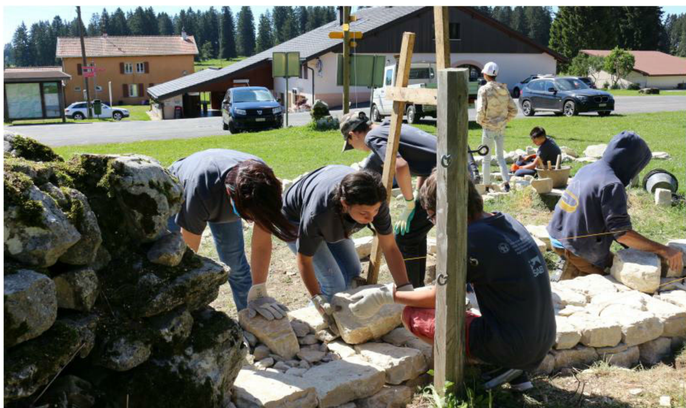
Cinq tonnes de blocs de calcaire ont été nécessaires pour ériger le mur.
